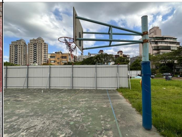
籃球柱生鏽脫漆老舊情形
